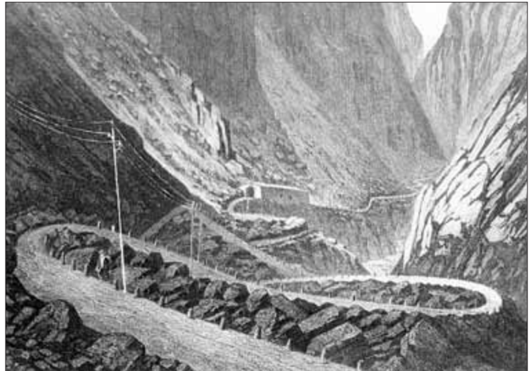
Telegrafenleitung über den Gotthard
